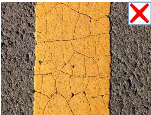
图 7-4-2 标线裂缝
