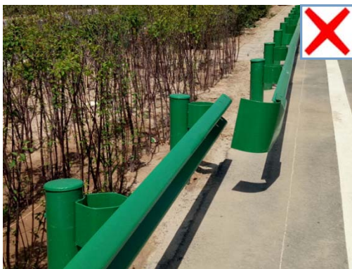
图 4-4-4 立柱安装错位
