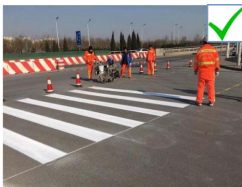
图 7-2-2 标线封闭施工
