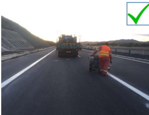
图 7-2-1 新铺沥青路面标线施工
