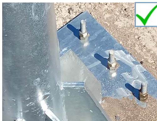
图 6-2-7 紧固件安装
