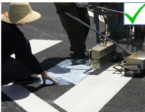
图 7-2-4 标线施工保护
