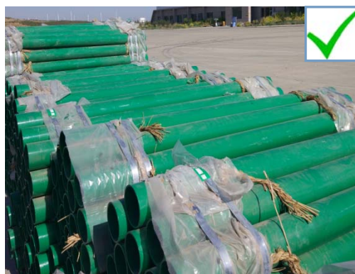
图 3-2-2 钢带下应有保护层
