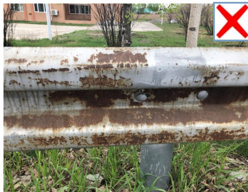
图 4-4-2 护栏板锈蚀
