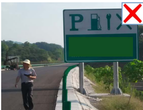
图 6-3-4 标志板内边缘距路肩边缘线距离不合格
