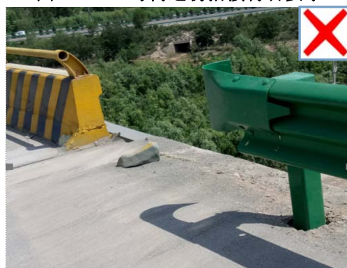
图 4-4-9 与构造物搭接处不符合要求
