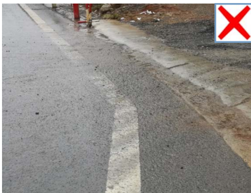
图 7-4-1 标线线形不流畅,出现折线
