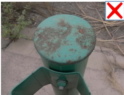
图 4-4-1 立柱柱帽锈蚀
