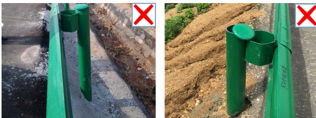
图 4-3-1 立柱外边缘距路肩边线距离不合格
