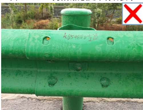
图 4-4-8 护栏板之间搭接不符合要求
