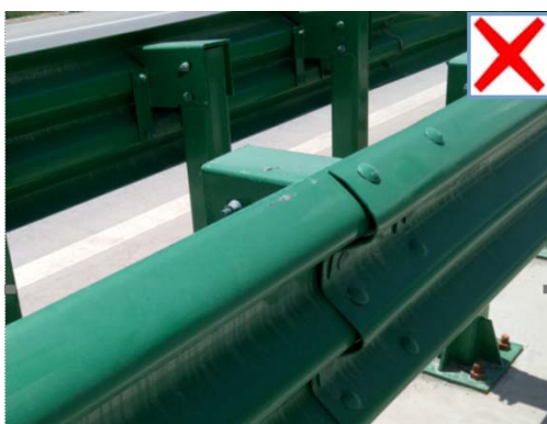
图 4-3-3 护栏搭接错误
