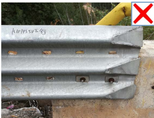
图 4-4-6 与桥梁搭接处不符合要求
